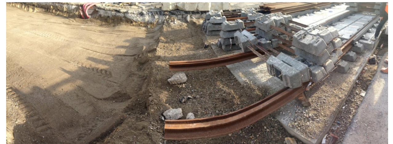
Illustration 2. Diaporama des opérations de réalisation d'une plateforme ferroviaire, source : Groupement SARA
