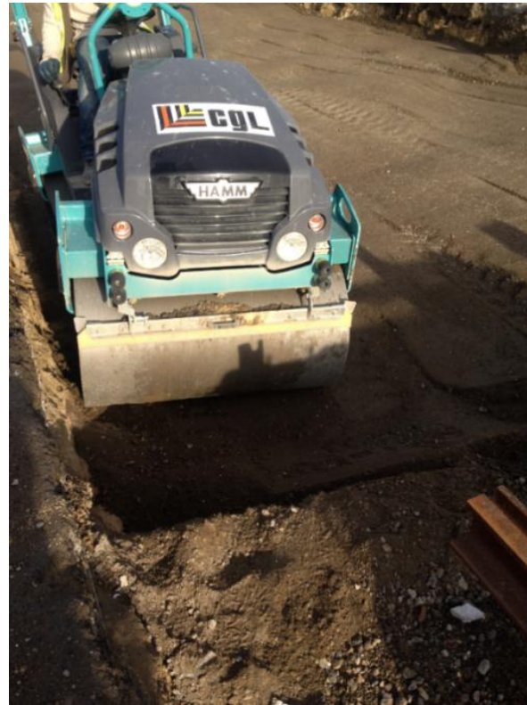
Illustration 3. Terrassement et nivellement, source SYSTRA
