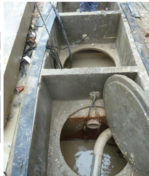
Illustration 8. Décanteur sur une ZAC dans les Hauts-de-Seine, source SYSTRA
